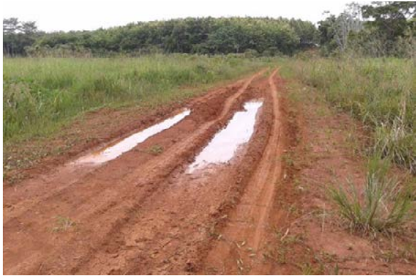
Figura 1. Camino sin inclinación lateral (bombeo), sin drenajes ni cunetas laterales, que permitan evacuar el agua acumulada por lluvia. Este camino es de categoría aceptable, transitable gracias a su pendiente <10%. De no recibir el mantenimiento adecuado puede degenerar en categoría inaceptable.
