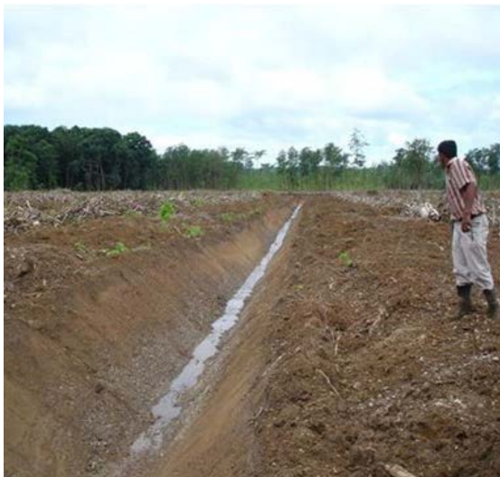
Figura 3. Construcción de drenajes primarios y secundarios en terrenos planos con exceso de lluvia. Pacífico Sur de Costa Rica.
