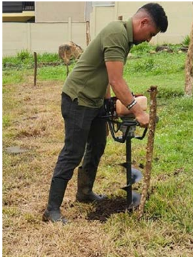
Figura 6. Uso de la hoyadora para lograr una preparación mínima del suelo alrededor del árbol, en sitios donde no sea posible el uso de maquinaria.
