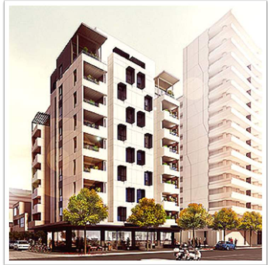
Edificio de apartamentos Forté, acabado en el año 2012 en Melbourne (Australia). 33 metros de altura y 10 plantas, construido a partir de paneles de madera contra-laminada (CLT)
