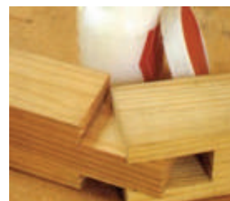
Fuente: www.teycubermadera.com Figura 42. Empalme a espiga.
