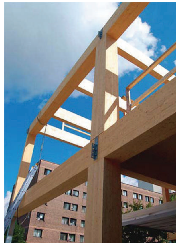
Fuente: www.cadamda.org.org Figura 52. Viga sobre pilar
