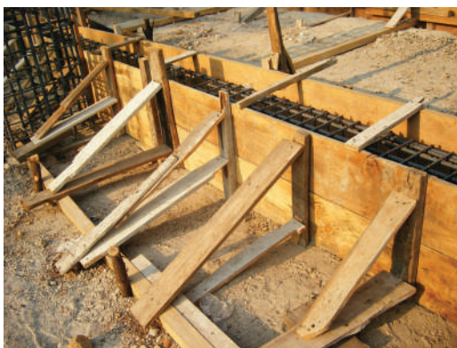
Fuente: www.arquienguate.blogspot.com Figura 3. Uso temporal en formaleta
