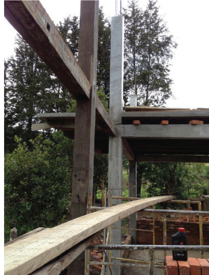
Fuente: www.casa-lavandablogspot.com Figura 54. Viga contra pilar
