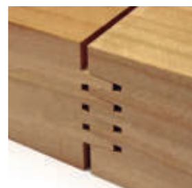
Fuente: www.teycubermadera.com Figura 40. Empalme con dientes.
